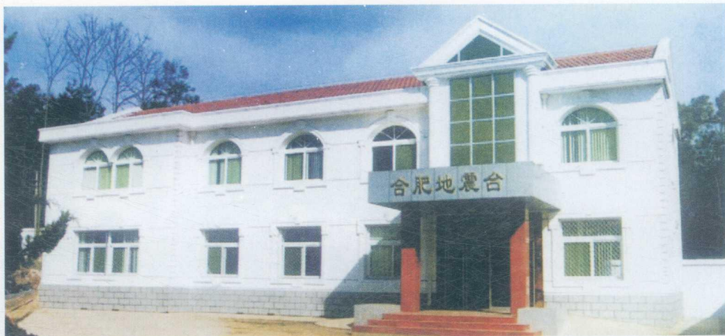
1999年建成的合肥国家数字地震台监测楼
