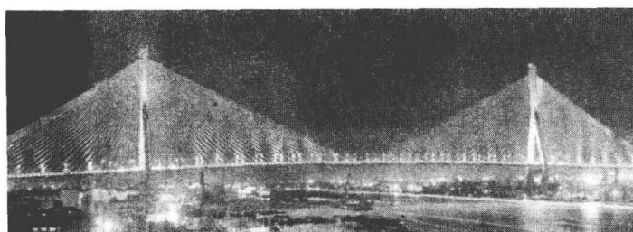
图 1-7 杨浦大桥主桥
