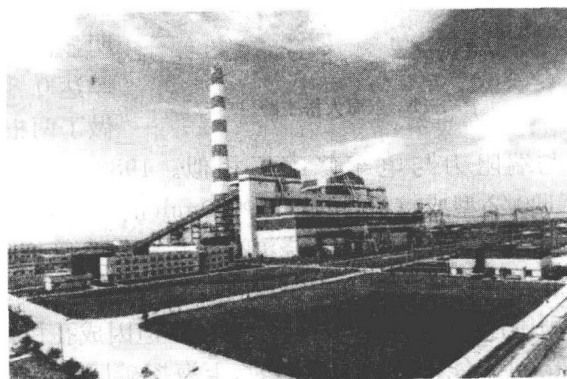
图 1-9 建于 H 型钢桩上的扬州第二发电厂
