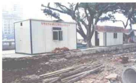
广州街头建筑工地活动房屋。
