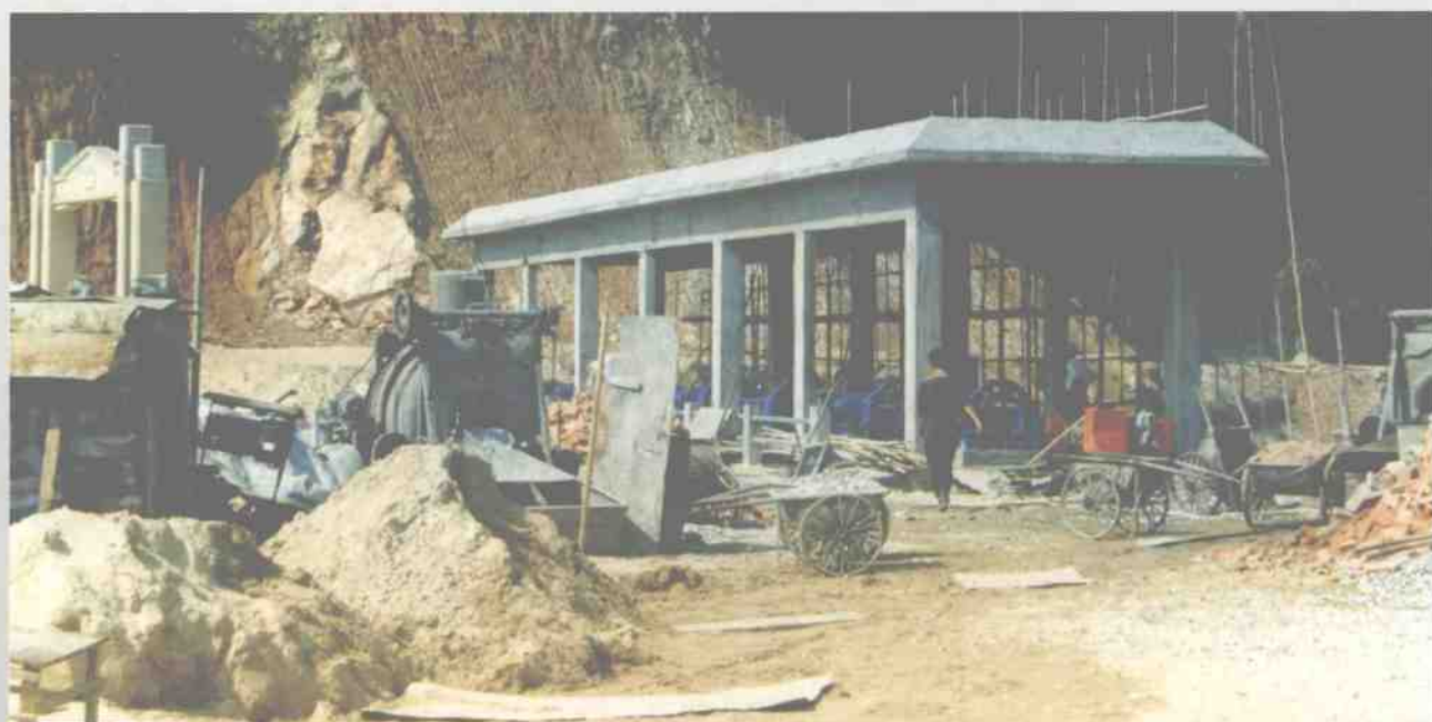
水利建设工地一角。
