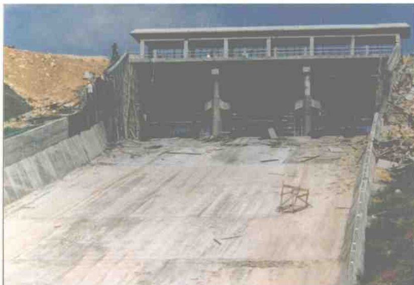
金坑水库泻洪闸。
