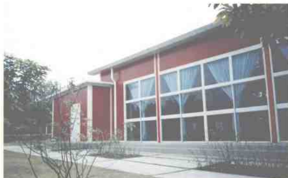
组合房屋之一(办公室、会议厅)。
