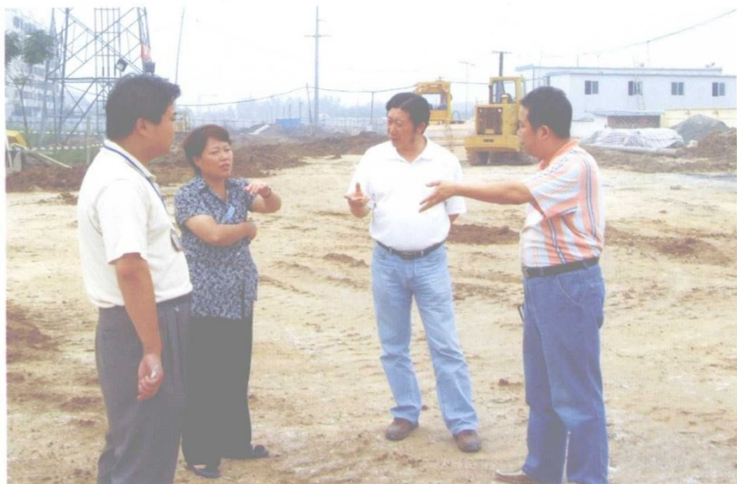
优秀企业家、西安众和市政工程监理咨询有限公司总经理 谭陇海（右二）在工地检查工作
