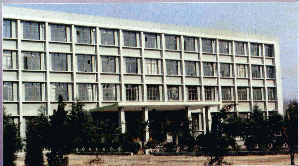
中共新蔡县委办公楼
