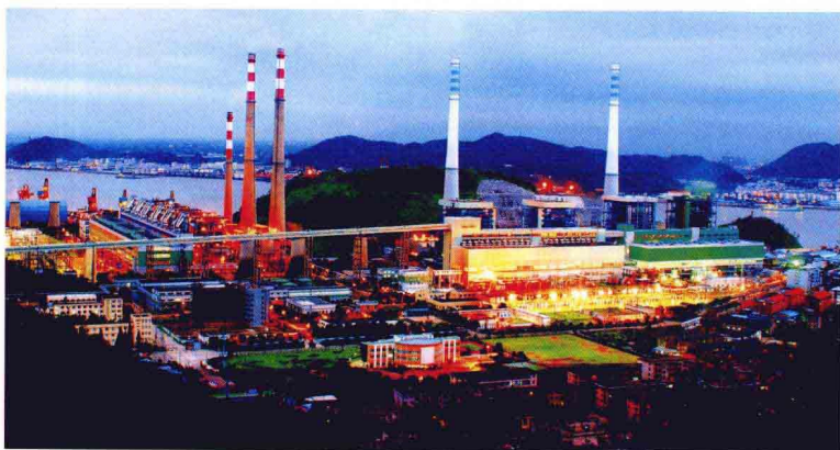
▶ 台州发电厂是国家“六五”、“七五”计划期间发展建设起来的大型港口电厂，总装机容量达1460MW，被人们誉为“浙江东南经济腾飞的翅膀”。图为浙江最大的火力发电厂——台州发电厂。
