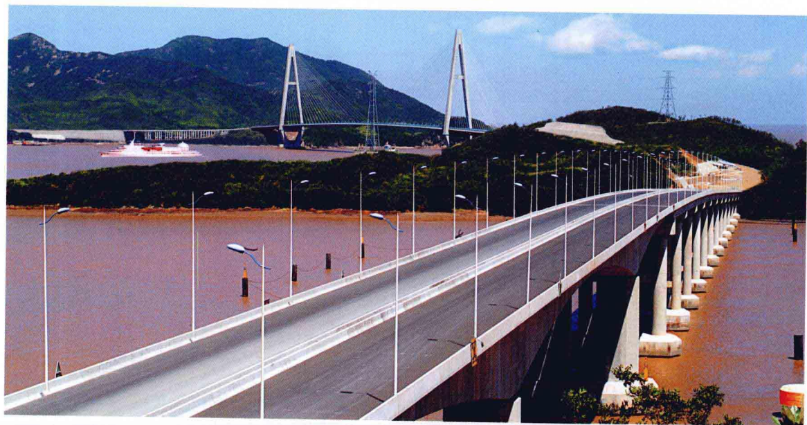
▲ 舟山桃天门大桥于2005年1月建成，是舟山大陆连岛工程的第三座跨海大桥。
