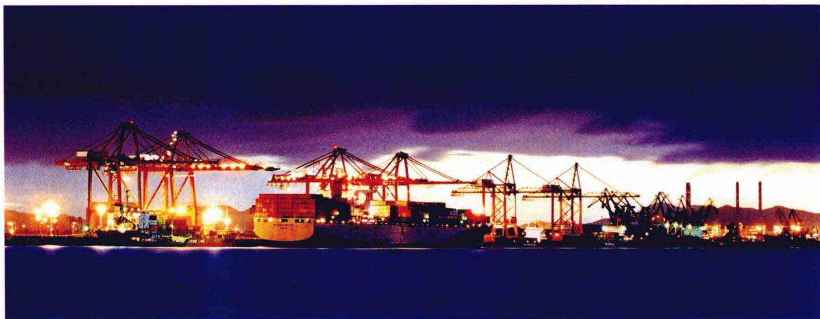
▲ 宁波北仑港区是我国目前规模最大的进口铁矿中转基地。图为深水港口北仑港夜景。
