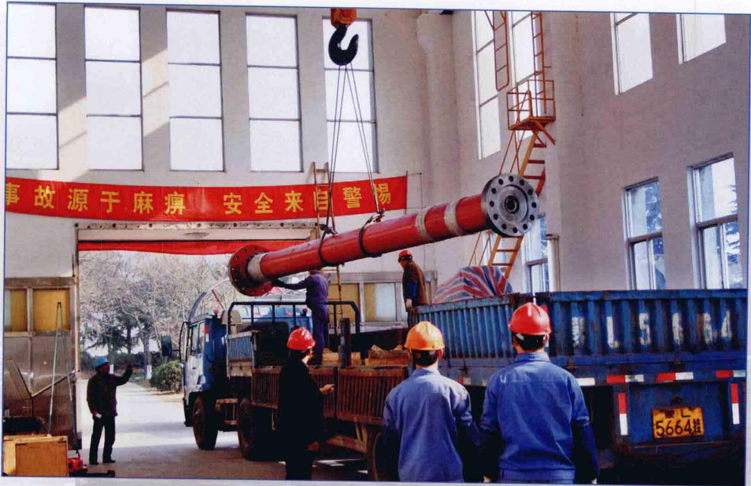
■ 2008年9月，南水北调东线一期工程江都四站更新改造工程开工建设。
