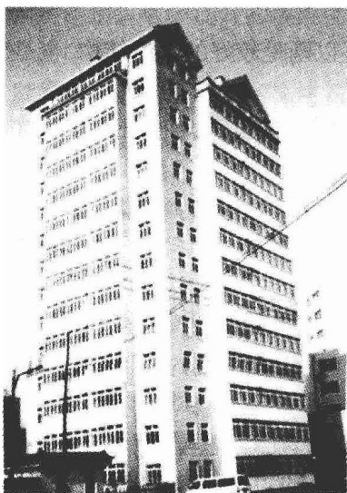
图 1-3 盘锦配筋砌块建筑
