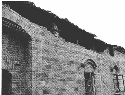
图 1.1-7 江西九江砖外墙土内横墙承重房屋
