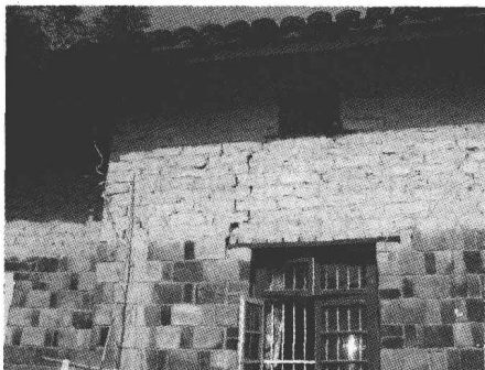
图 1.1-4 江西九江下砖上土坯墙承重房屋
