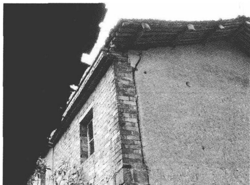
图 1.1-6 浙江文成土山墙承重房屋
