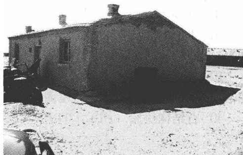
图 1.1-9 内蒙古砖柱土坯山墙承重房屋
