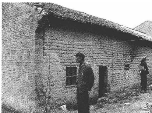
图 1.1-8 江西九江砖外山墙土纵横墙承重房屋
