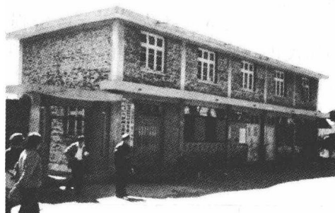
图 1.1-13 砖混结构房屋
