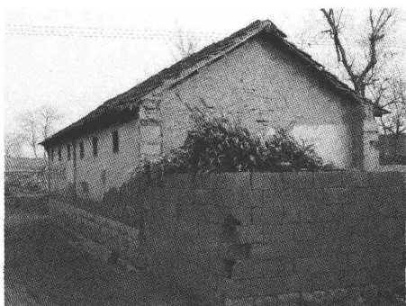
图 1.1-1 土坯墙体承重房屋
