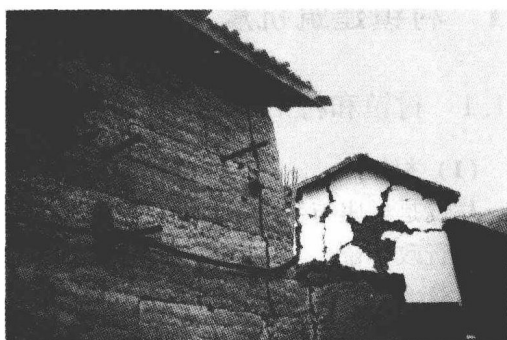
图 1.1-2 夯土墙体承重房屋
