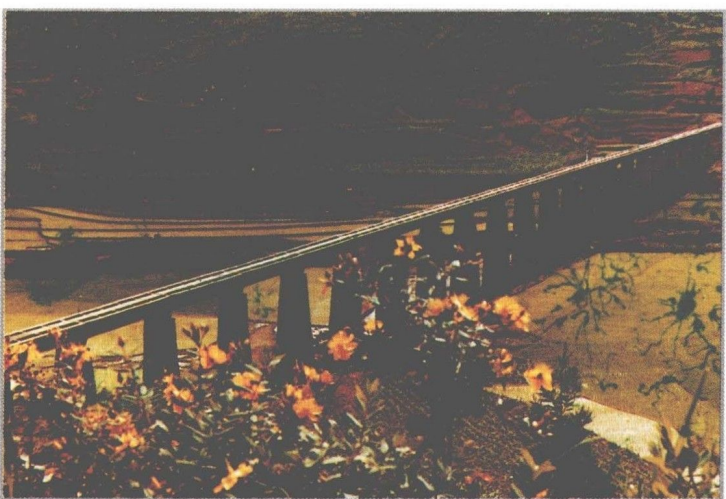
幸福水库配套引灌工程
