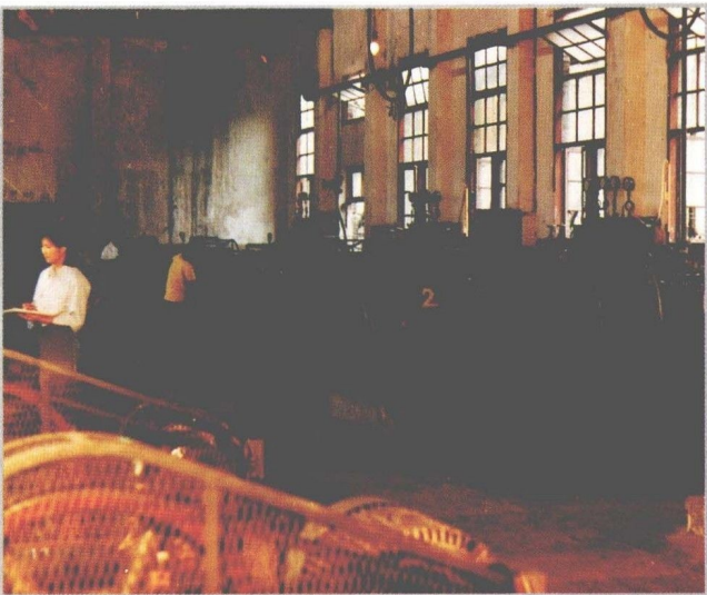
三板桥水电站运行车间
