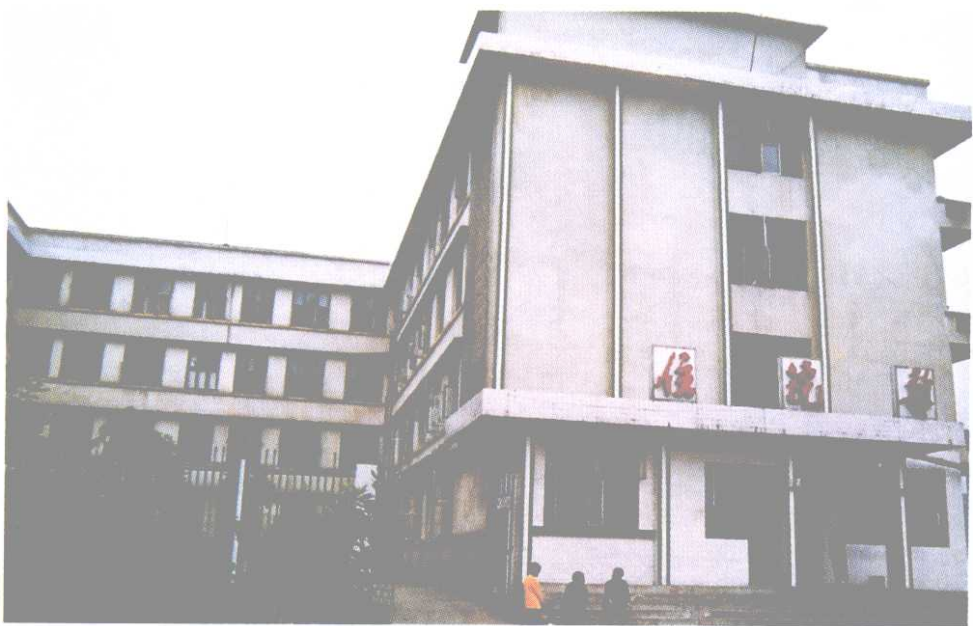
县人民医院住院部
