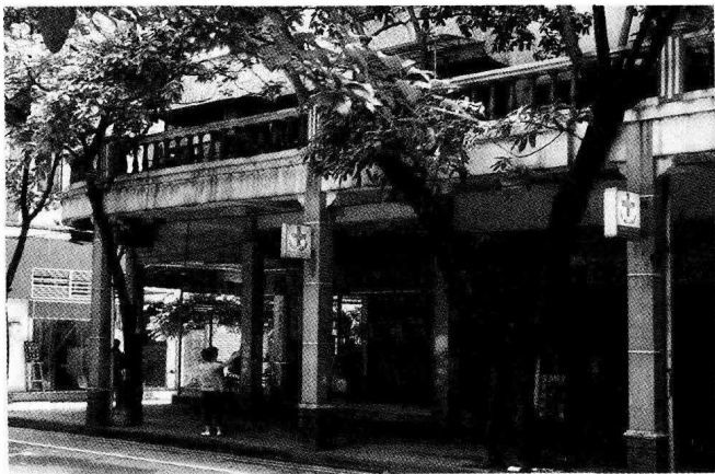
骑楼廊的连接体
