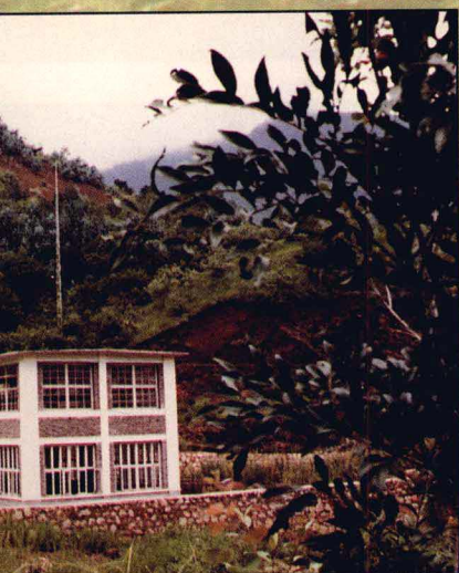
鸡足山水电站
