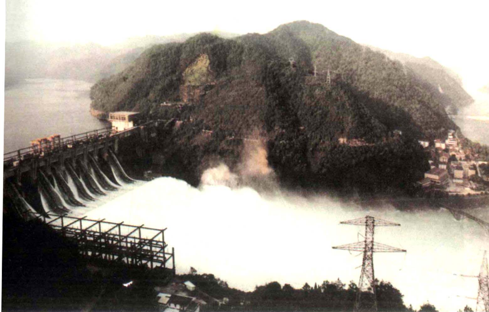
新安江水电站
