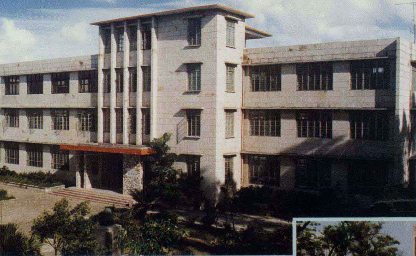
斗门县图书馆新馆于1987年1月落成， 建筑面积 1,210平方米。
