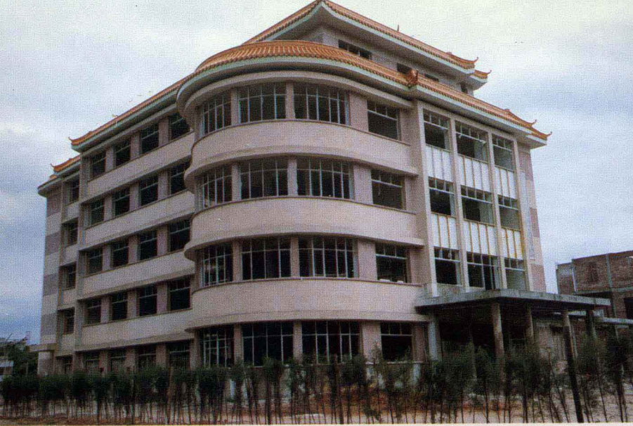
梅县图书馆新馆占地 13,200 平方米， 建筑面积 4,800 平方米。
