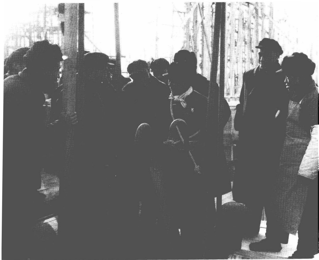
周恩来总理视察人民大会堂建设工地
