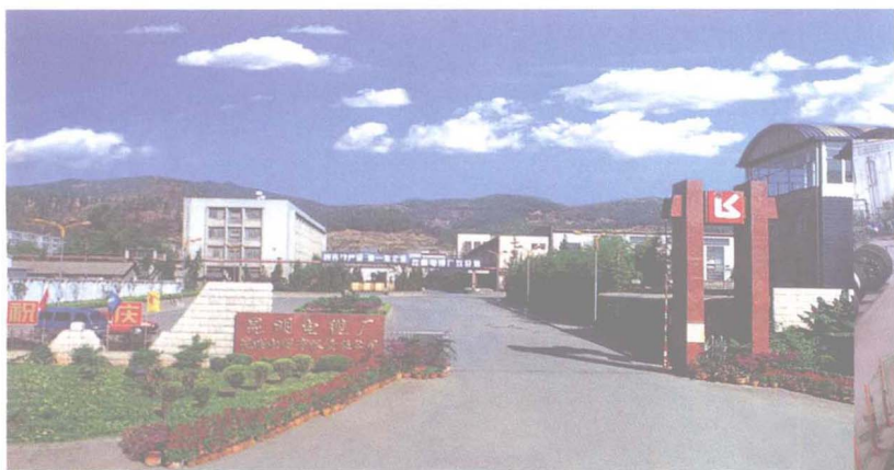
1939年建成投产的昆明电缆厂新貌
