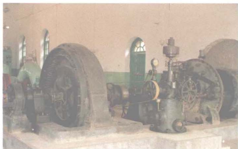
一九一一年中国第一个水 电站引进西门子发电机组
