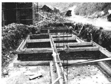
钢筋混凝土地圈梁钢筋
