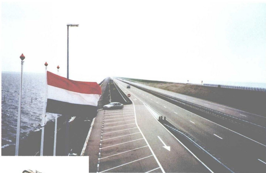
▲ 举世闻名的须德海拦海大坝
