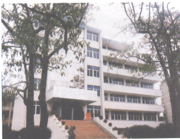
福州市殡仪馆办公大楼。
