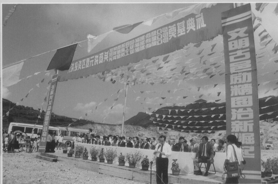
50平方公里的福清元洪投资区破土动工
