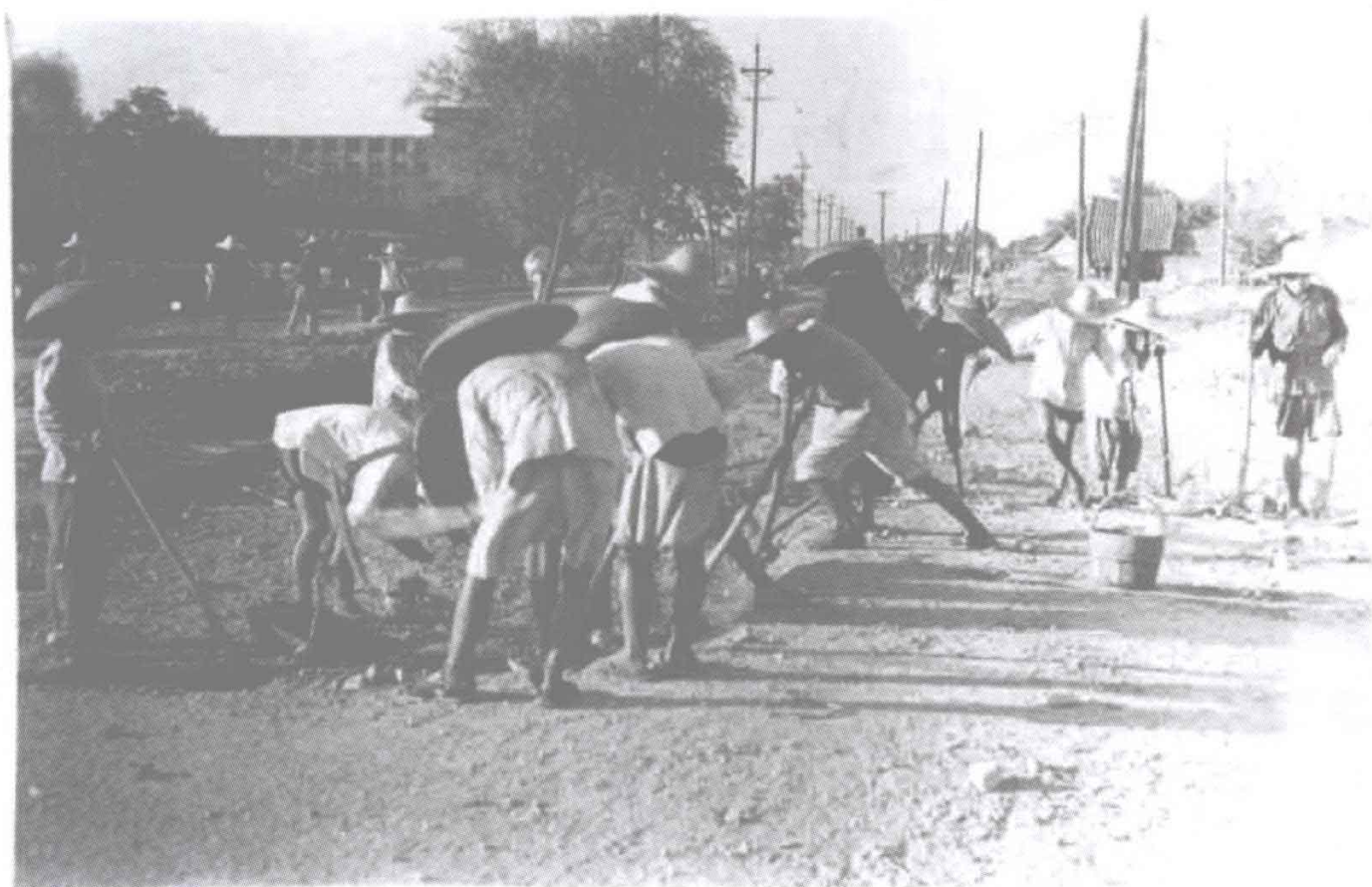
1959年东大路（今韶山路）破土施工 ▲
