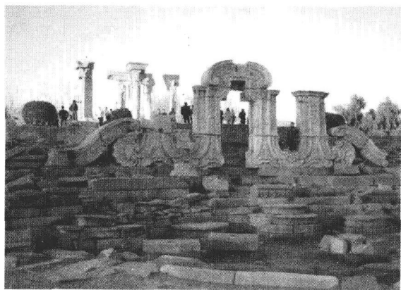
图11 被烧毁后的圆明园只剩下断壁残垣
