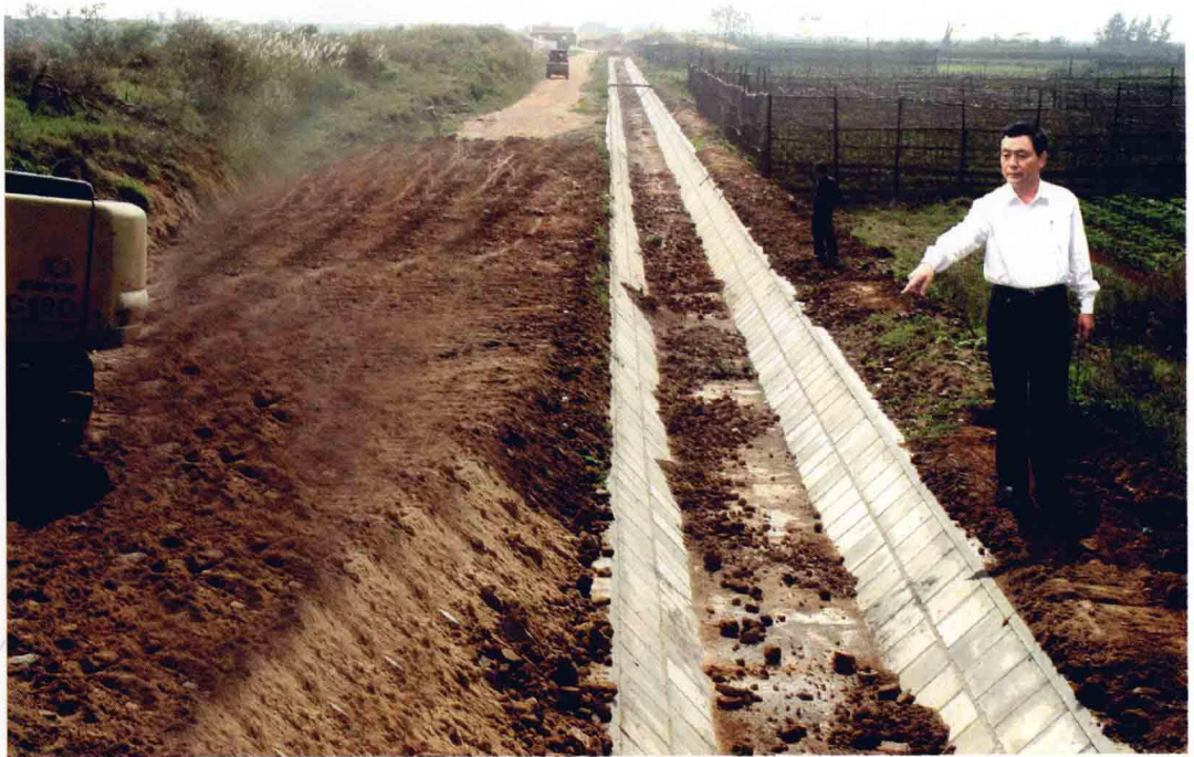
综合整治琉川洋农田排灌系统渠道之一 (图为村党支部书记李少锋在检查质量)
