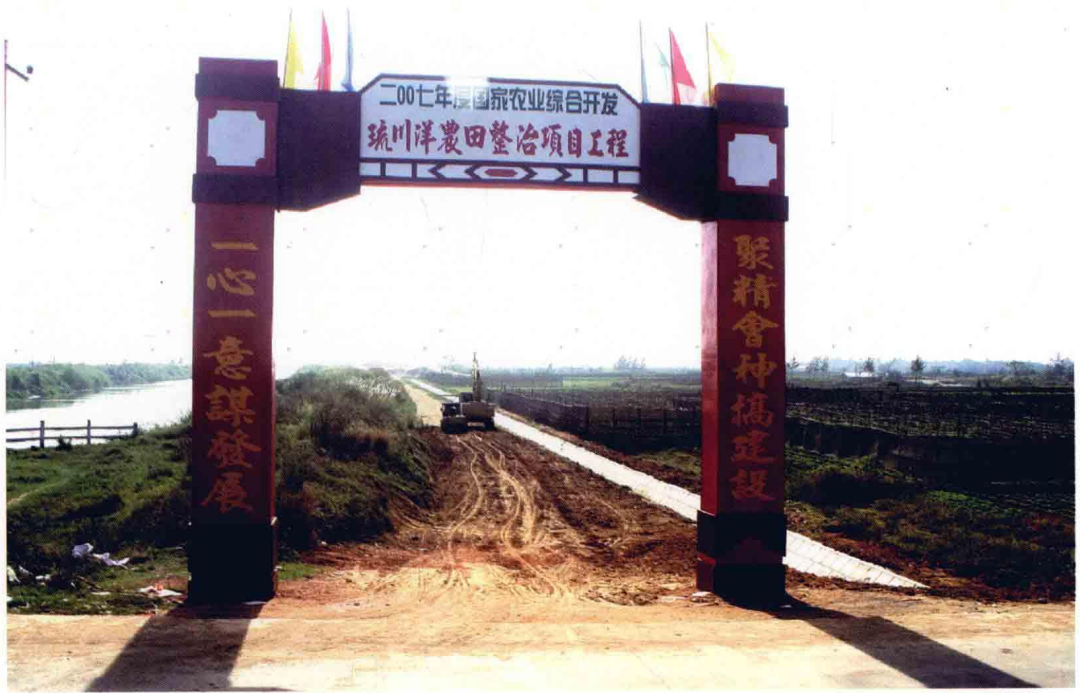
政府投资一千余万元对琉川洋农田综合治理典礼彩门(2007年11月动工)
