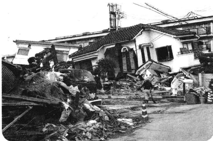
◆ 地震中倒塌的房屋
