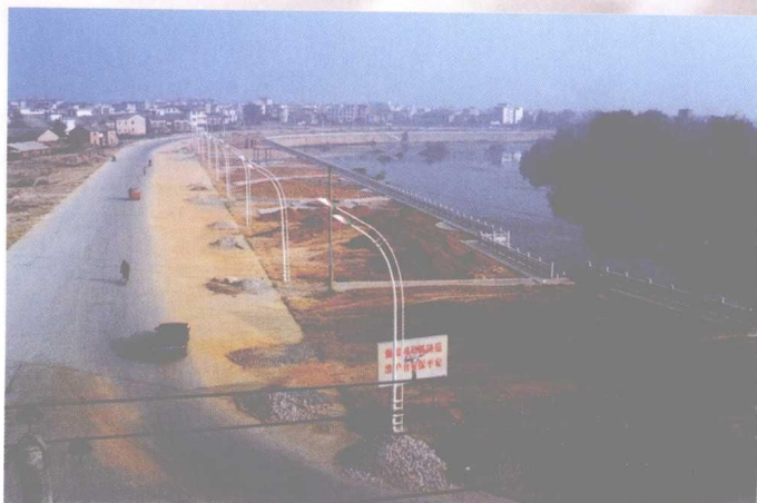
建设中的滨河路 (李盛开 摄)
