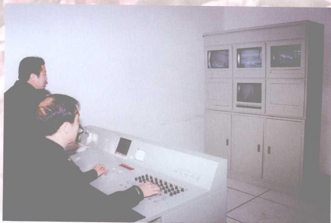
院监控室一角
