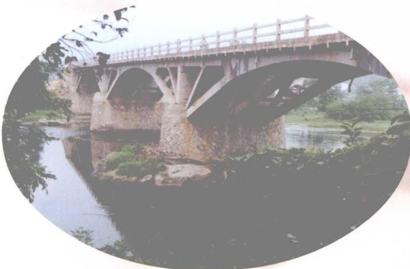
国家以工代赈项目升坊大桥
