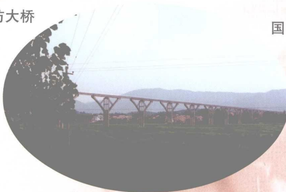
国家以工代赈项目坪里渡槽
