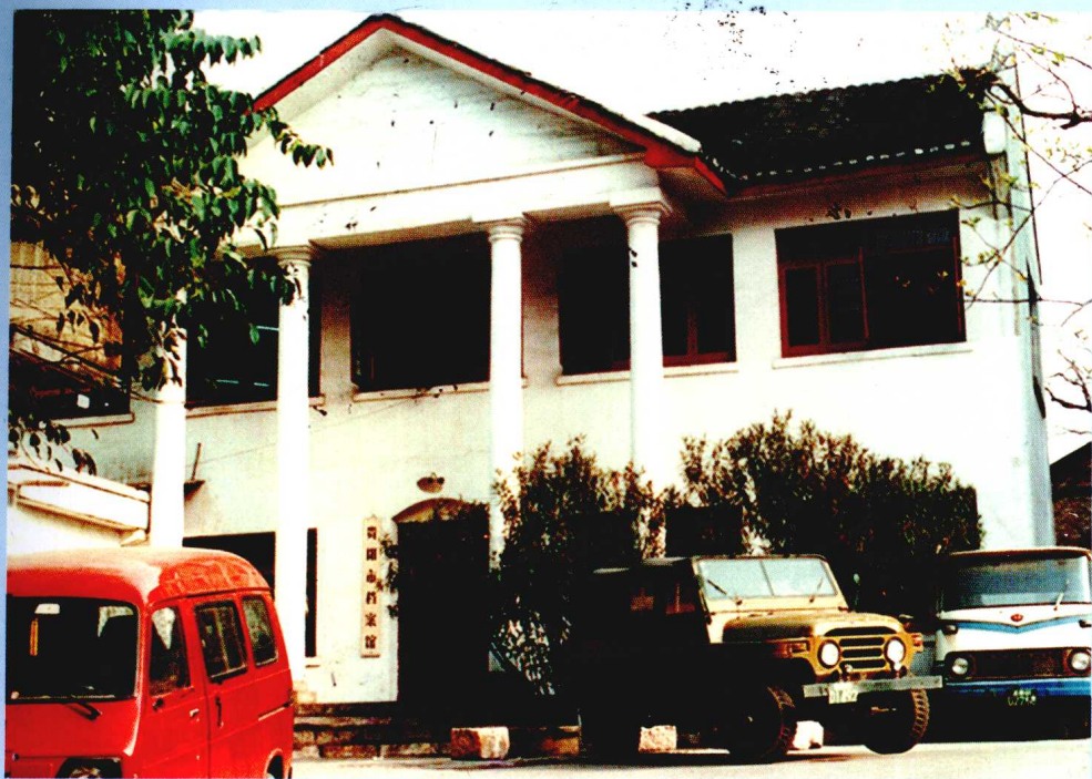
位于市政府大院后院的原贵阳市档案馆老楼
