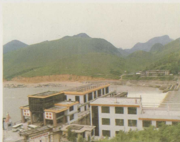
糯米滩水电厂
