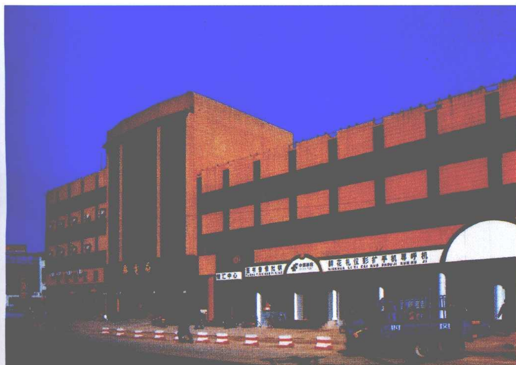
县邮政电信综合楼
