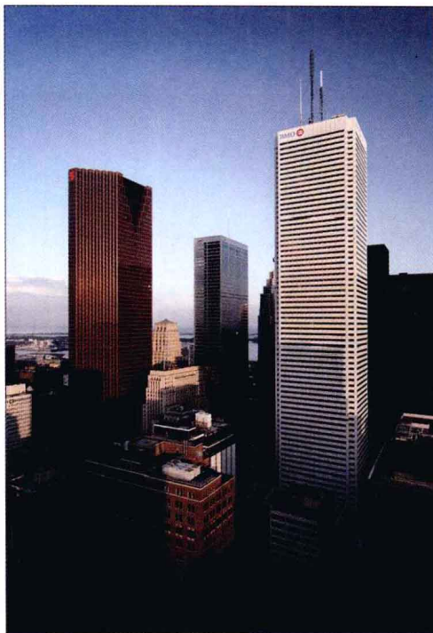
图1-3 采用广角镜头在较高处进行拍摄,减小建筑变形
