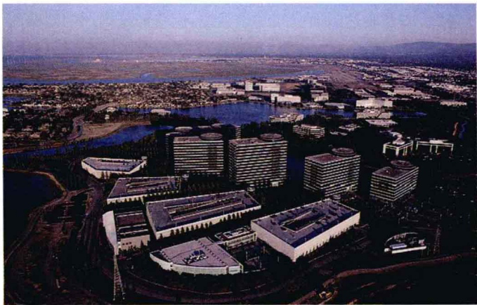
图1-10 为了反映建筑整体结构和周边关系,采用俯视角度拍摄
