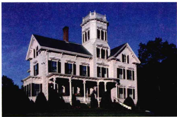
图1-6 将建筑整体全部纳入画面
