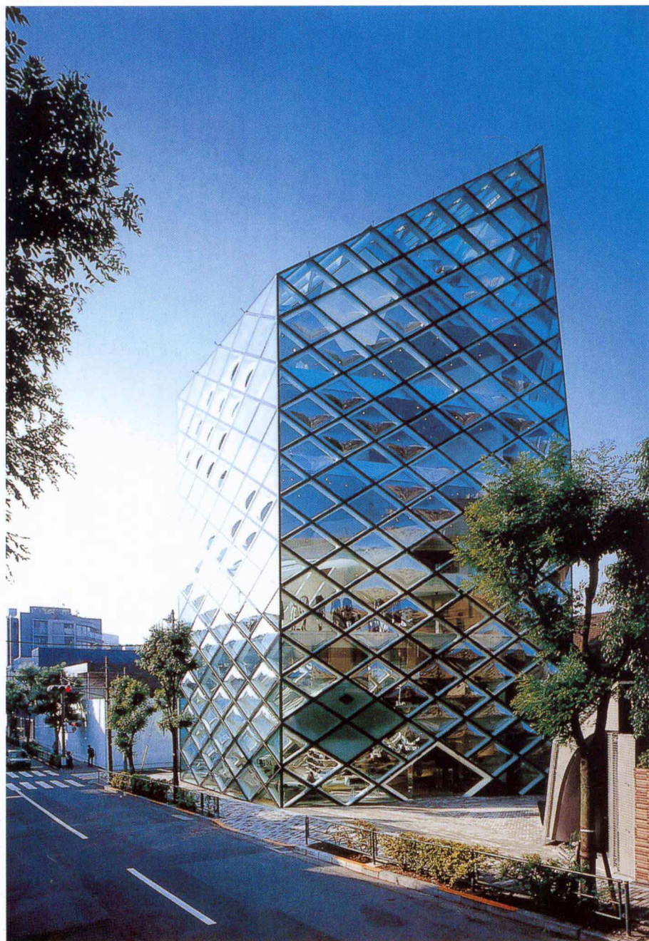
北侧立面全景 形成留有开放空间的街路
