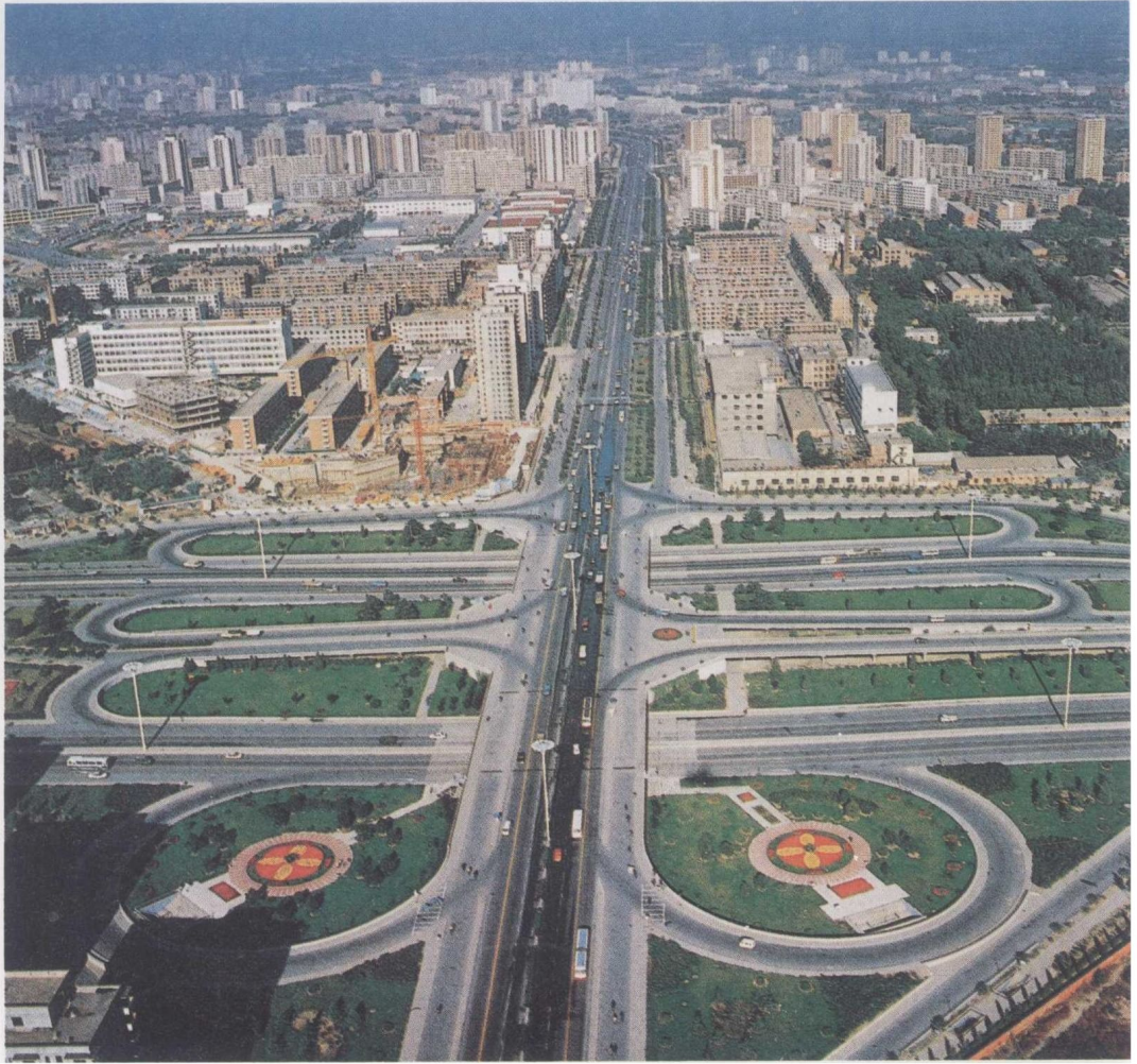
1984 年完成的三環路交匯處的三元立交橋體系。注意立交橋上及三環路上的自行車及自行車道，以及三環路上的綠化及十分寬餘的建築紅線寬度。這裏有「大馬路」主義的感覺嗎？
