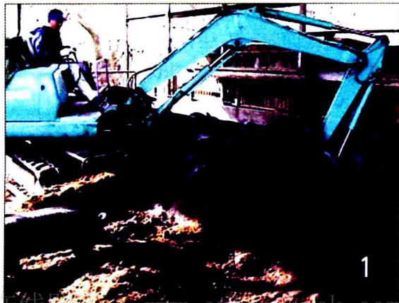
图 1-1 日本机械翻挖
