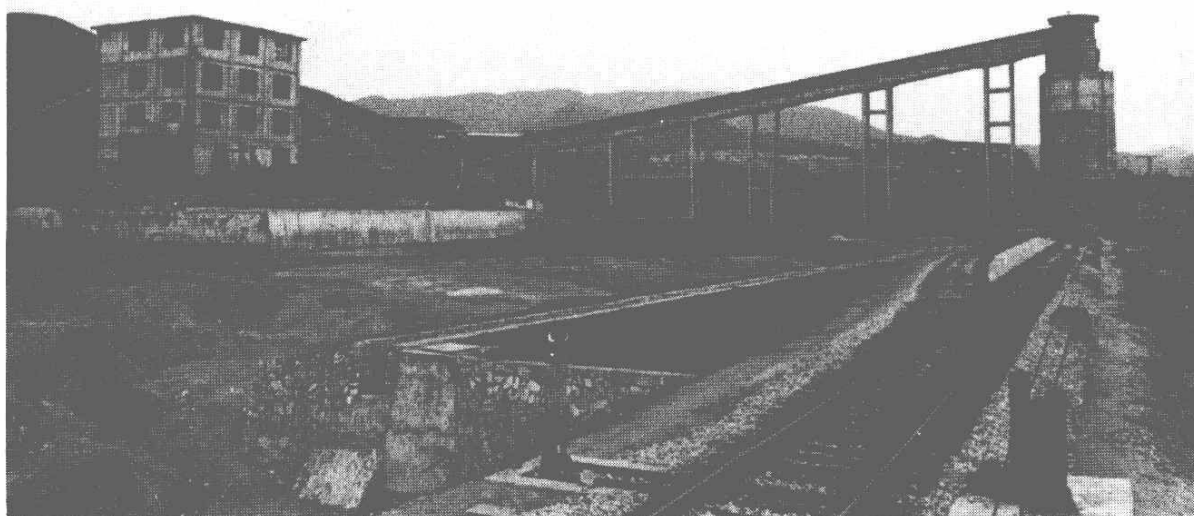
铺前煤矿自动装卸 运输线
