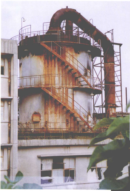
景德镇陶瓷厂喷雾干燥塔
