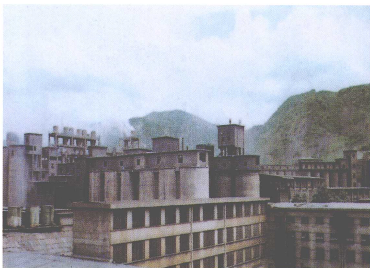
萍乡市水泥厂日产 800 吨 熟料的 4 台机立窑系统
