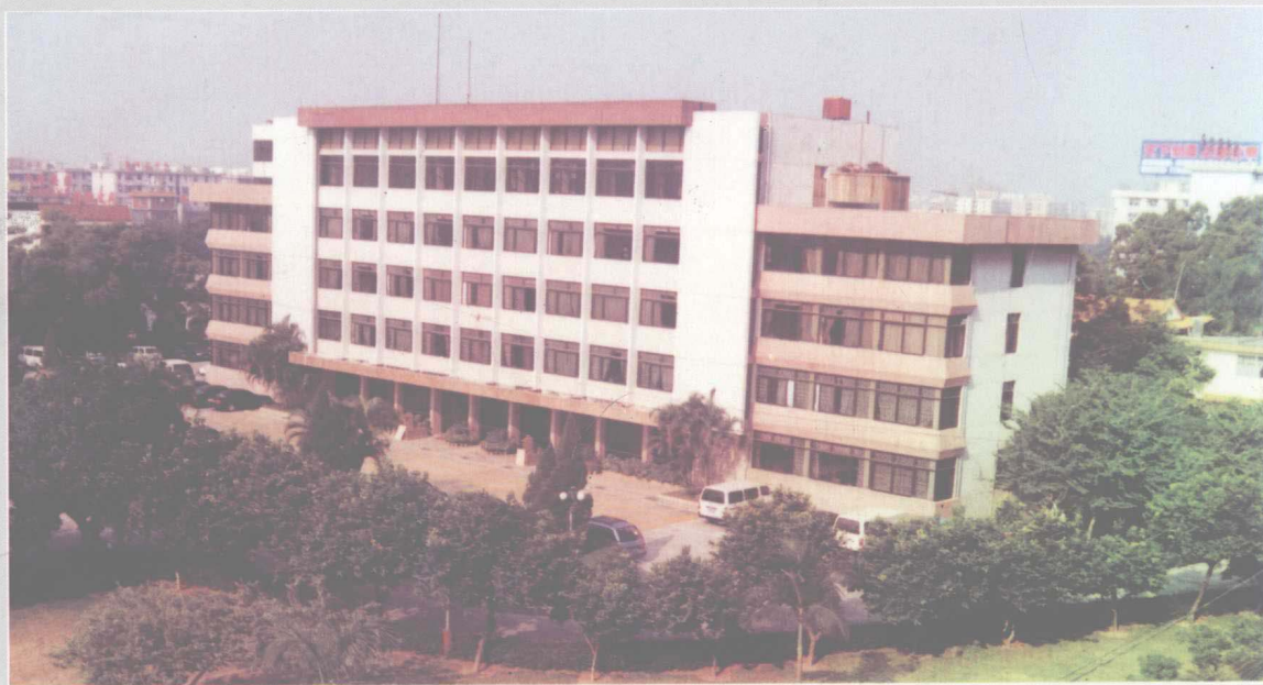
▶ 宝安县人民政府办公大楼
