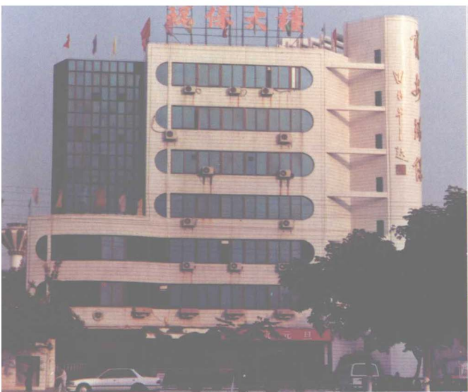
宝安县环保大楼
