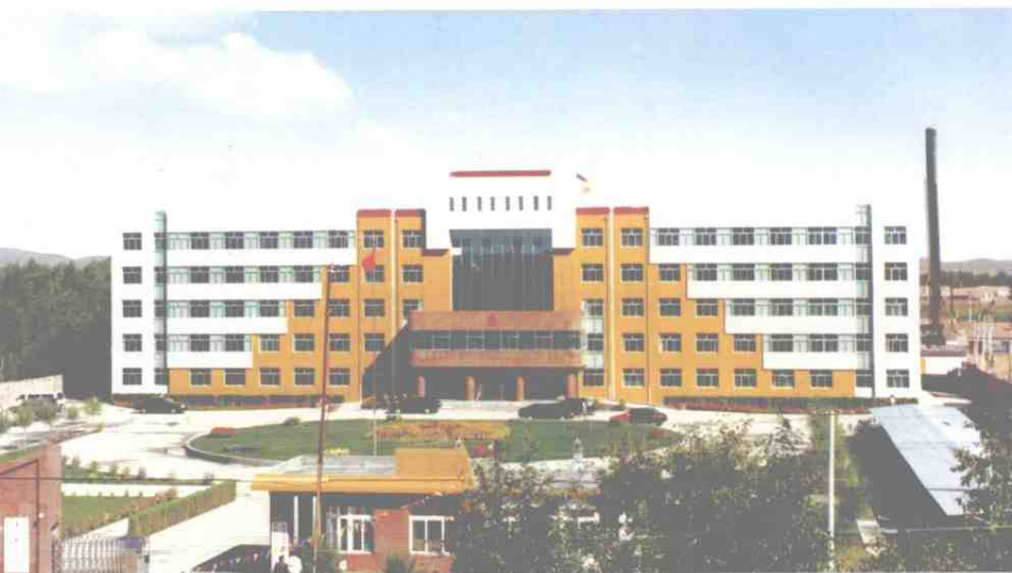
沽源县人民政府 办公大楼
