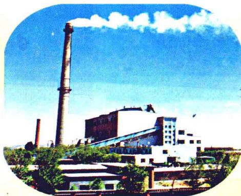
朝阳热电厂消烟除尘后的高架烟源
