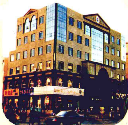
市环保局办公大楼
