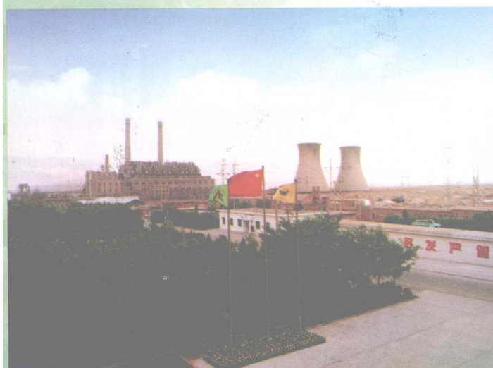
内蒙古乌达发电(集团)有限责任公司厂区全景
