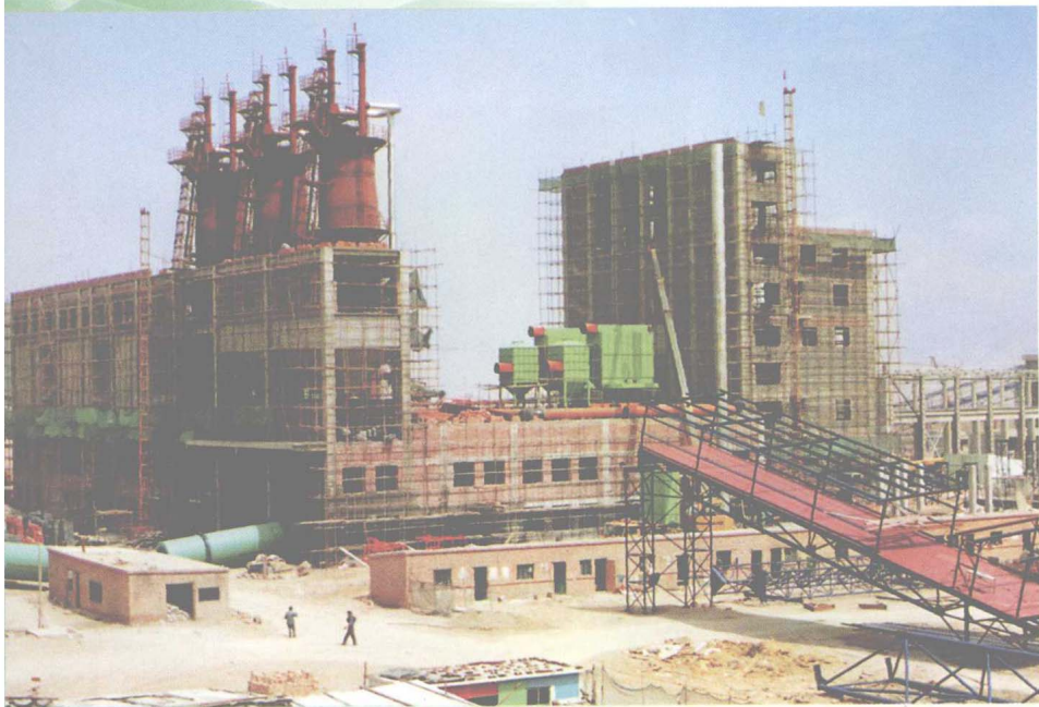
建设中的海吉氯碱工程
