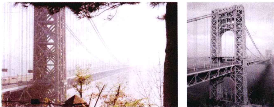
图 1-7 乔治—华盛顿桥 (George Washington Bridge)
