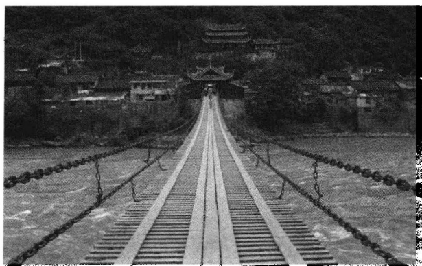
图 1.8 大渡桥横铁索寒——泸定桥
