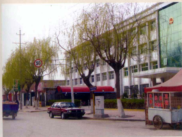
四凤坊原址。位于今县检察院与县法院之间，正对东关三元巷。
