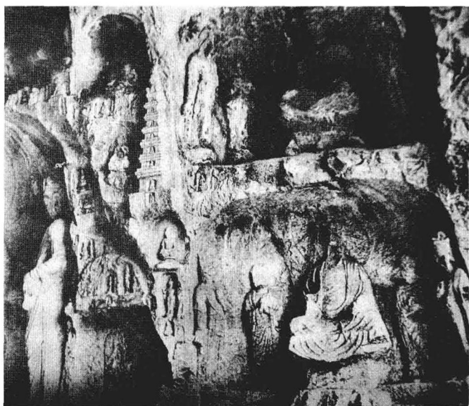
图一 老龙洞（669窟）左壁被盗佛塔
