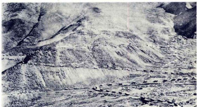
●青藏公路上,满载物资的汽车驶往拉萨,有力地支援了西藏的建设和发展
