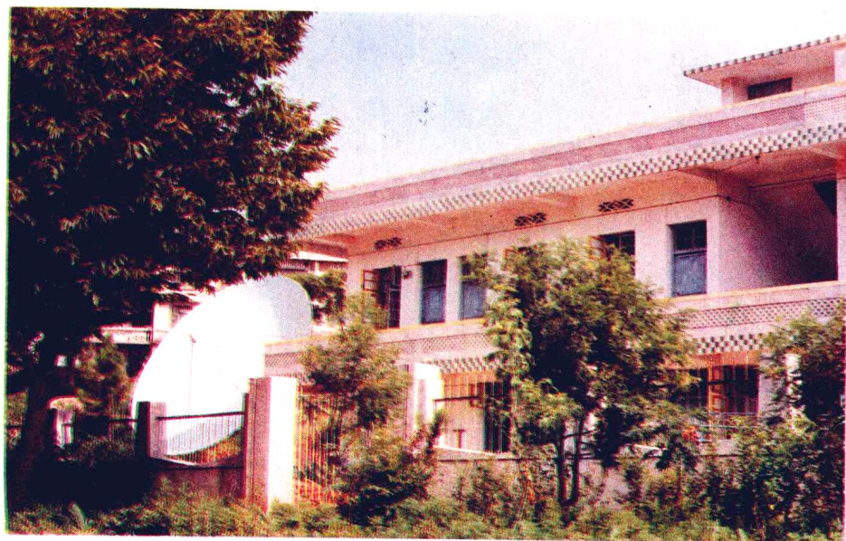
电教电视接收天线
