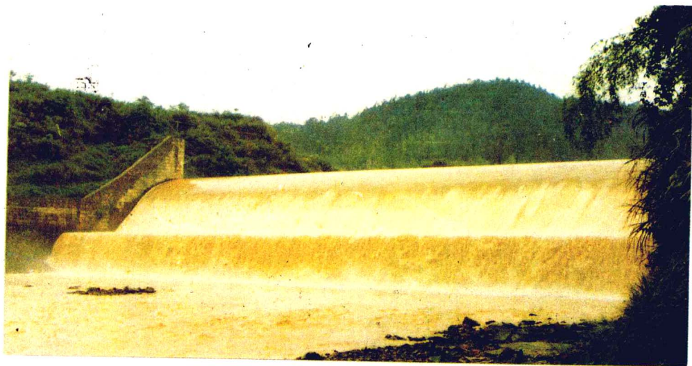
九曲水电站拦河坝
