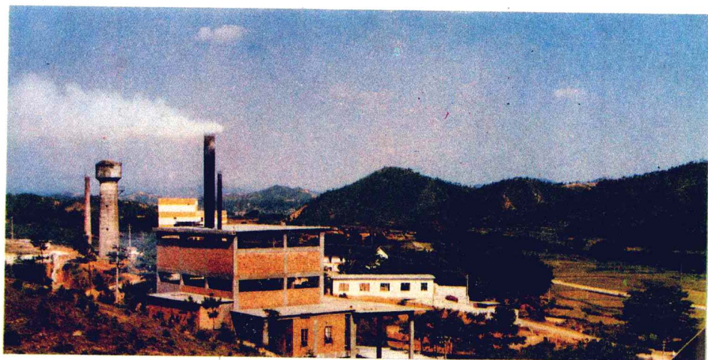
定南第二化工厂一角
