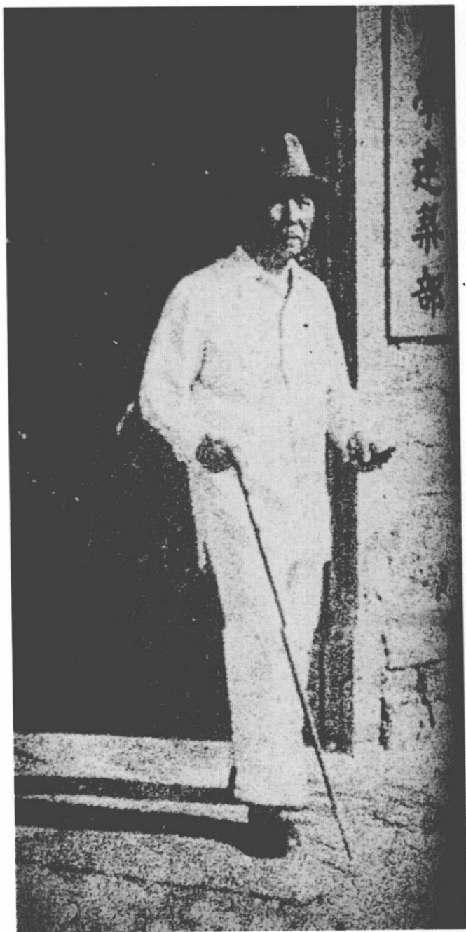
陈嘉庚十分关心 厦门大学扩建工程， 常到建筑部指导工作
