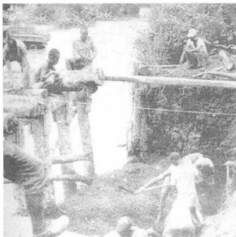
中國遠征軍正在緬甸修復一條被大水沖毀的橋梁。
