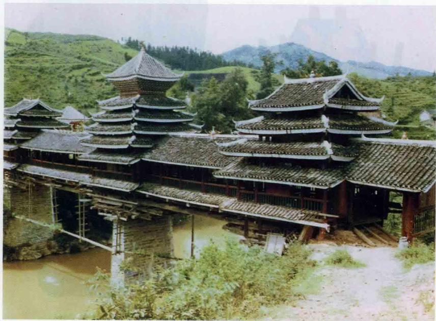
黎平縣地坪侗族風雨橋
