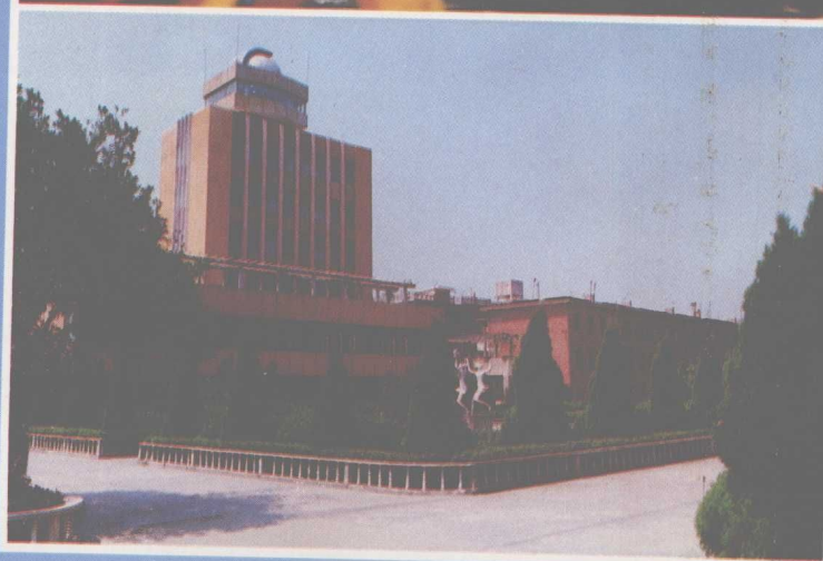
县第一中学科学楼
