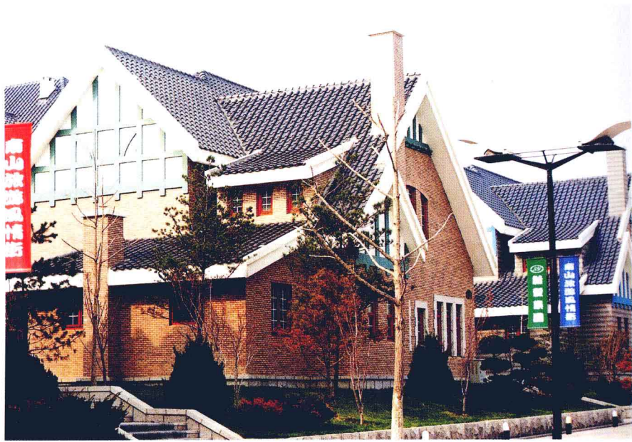
山墙的特别处理、厚重的屋顶、再加上老虎窗，体现了厚重，但又不乏活泼。
