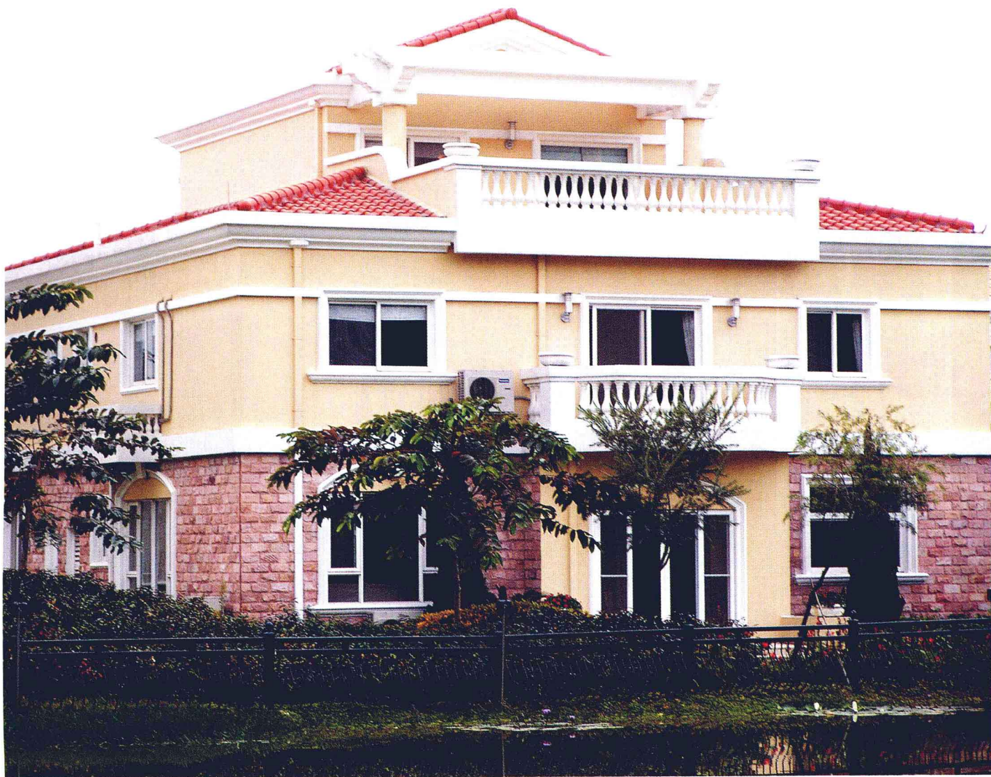
顶部阳台屋顶的突出处理，使本来平凡的住宅，冲满理性的活泼。
