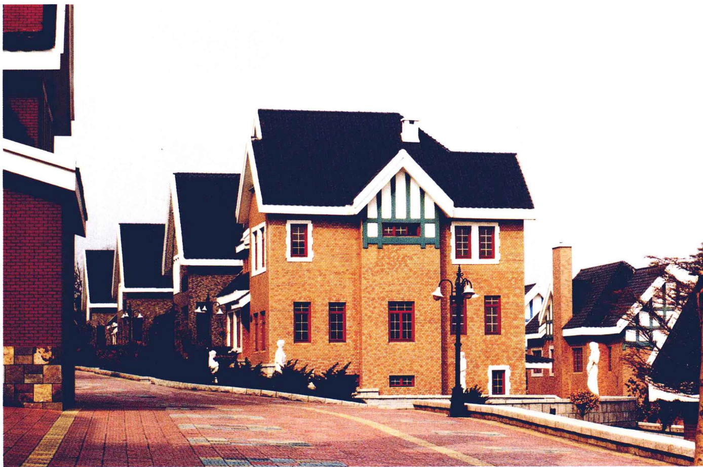
建筑立面突出处理，小窗与屋顶的白色套边使建筑生动、活泼。
